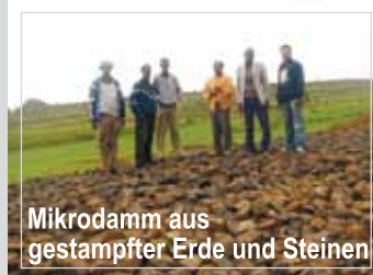
Bauarbeiten am Damm im April 2009
